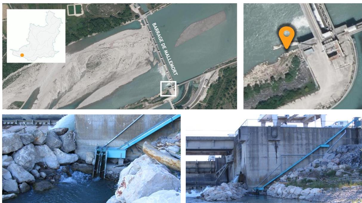
Figure 4 : Localisation du barrage de Mallemort et de la passe-piège sur la Durance et photos du dispositif
