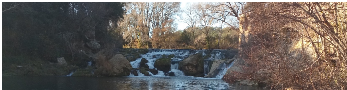
Figure 10 : Ouvrage de Sainte-Croix
