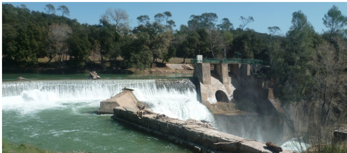
Figure 5 : Barrage d'Entraigues © Mairie de Canet des Maures
