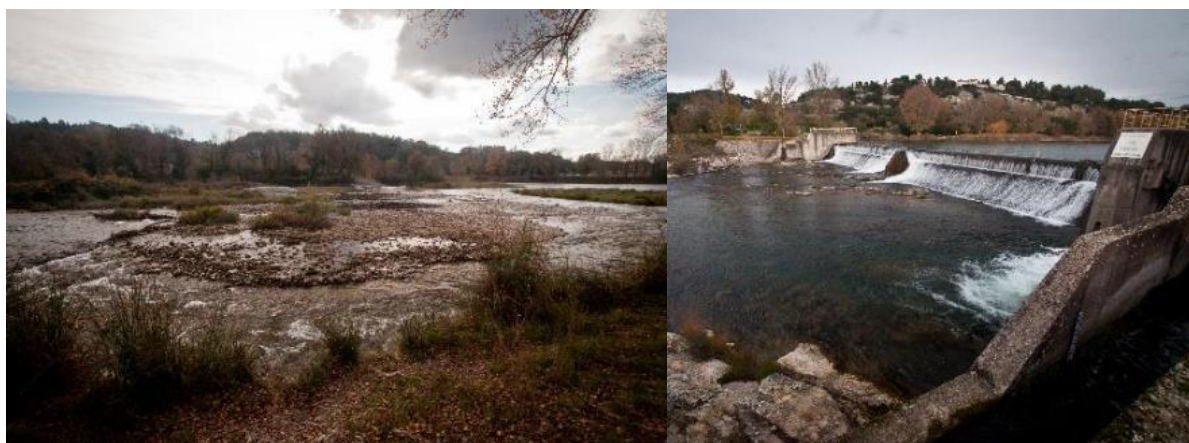
Figure 2 : Seuils en amont immédiat de Vinon-sur-Verdon (à gauche) et seuil « du boudin de Gréoux » (à droite).
