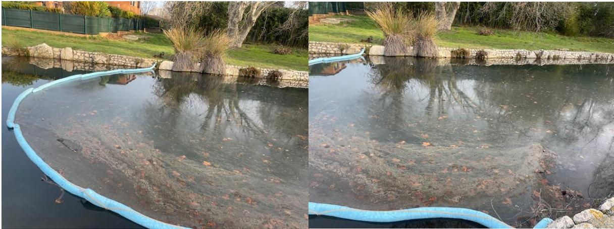
*Figure 5. Photos d'une pollution aux hydrocarbures contenue à l'aide de six barrages flottants sur le lac de la Tuilière*
