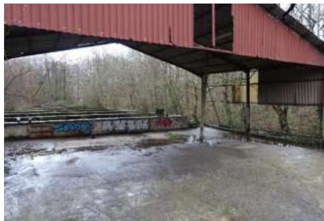
1 200m 2 imperméabilisés / déchets
