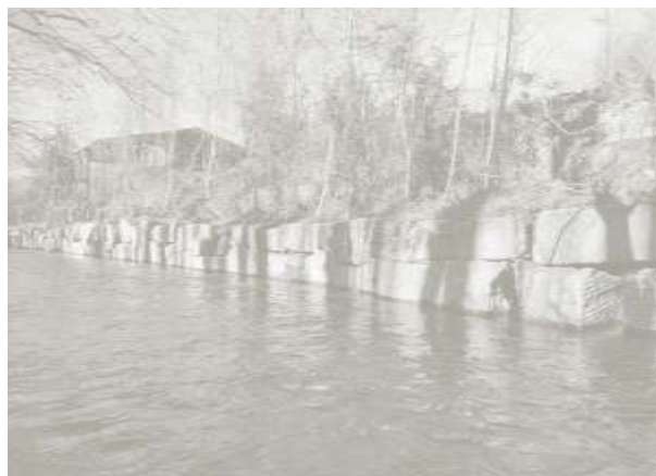
Piste enrochée de 60ml dans le lit mineur
