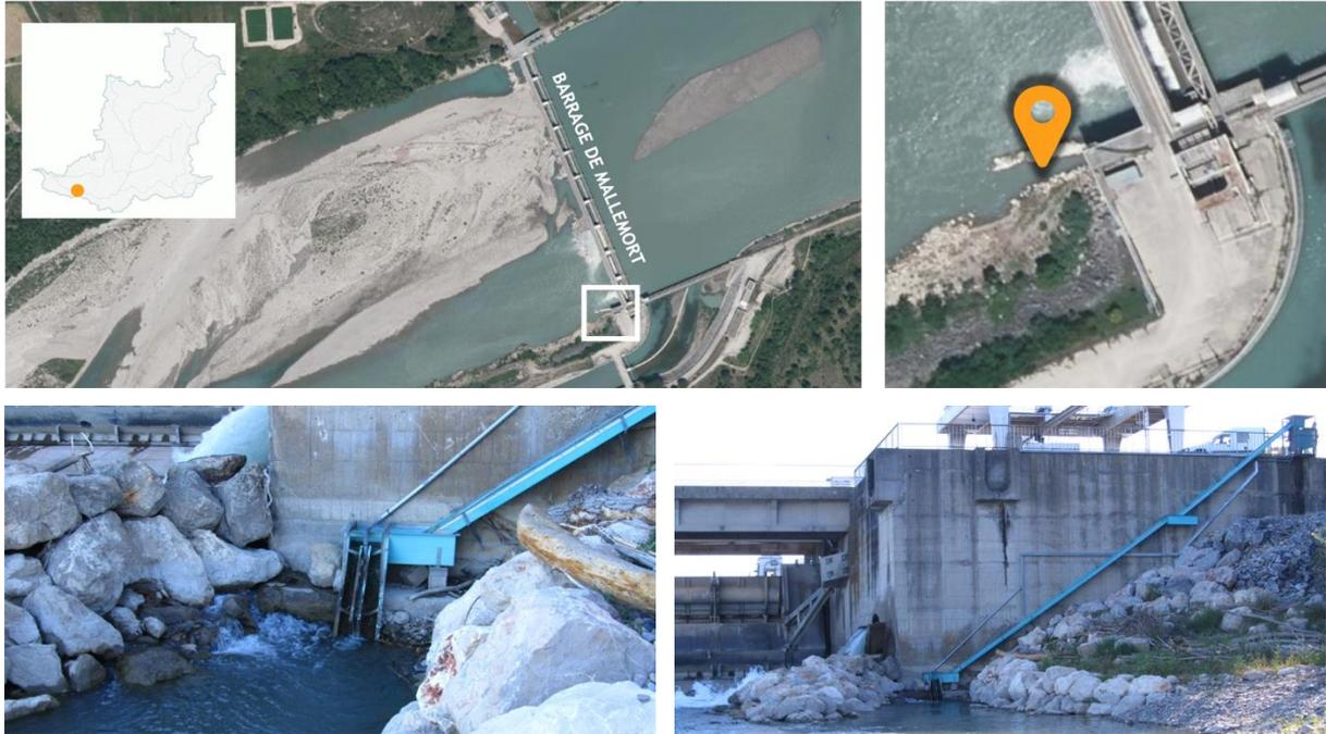
Figure 4 : Localisation du barrage de Mallemort sur le bassin de la Durance et de la passe-piège et photos du dispositif
