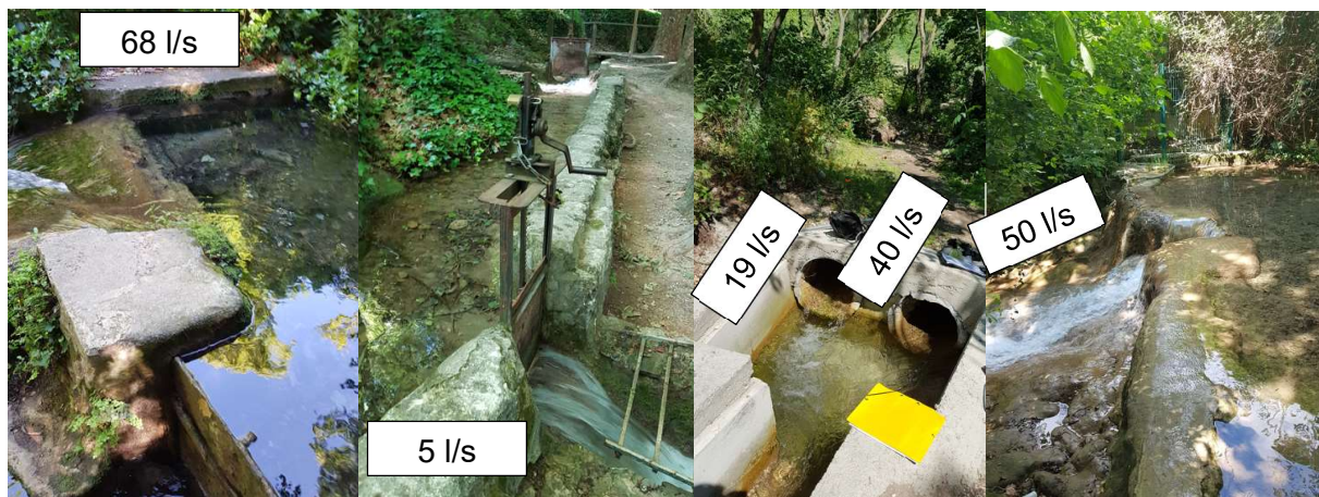
Photos 48, 49, 50 et 51 : Vues le 09/06/2021 du canal en amont de la cascade, de la vanne du CD13 sous la cascade, du Y raccordant la branche des Palettes et de la prise d'eau des Palettes.
