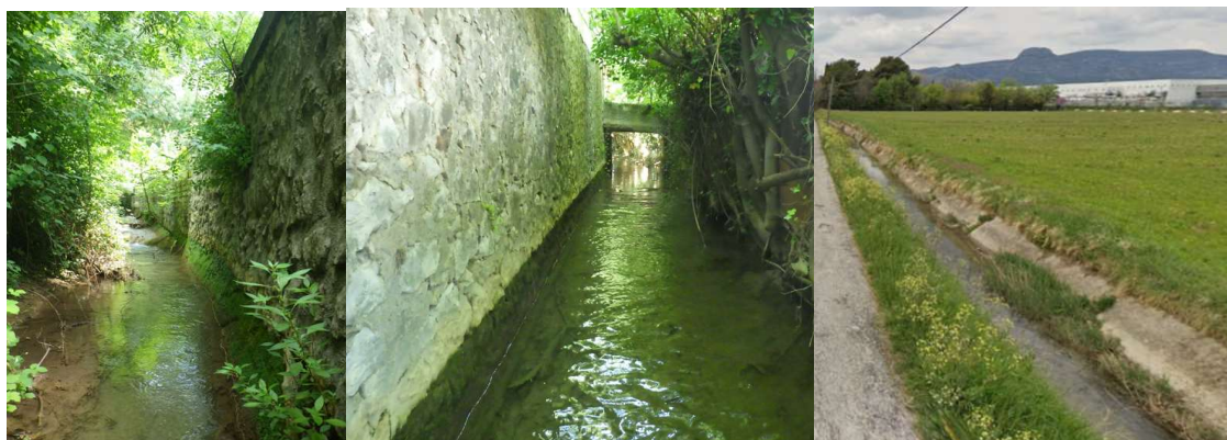
Photos 28, 29 et 30 : Vues du Fauge après la traversée de Gémenos et dans la traversée de la zone des Paluds.
