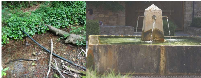
Photos 42 et 43 : Tuyau PEHD issu du bassin de la source alimentant la fontaine de l'Abbaye.
