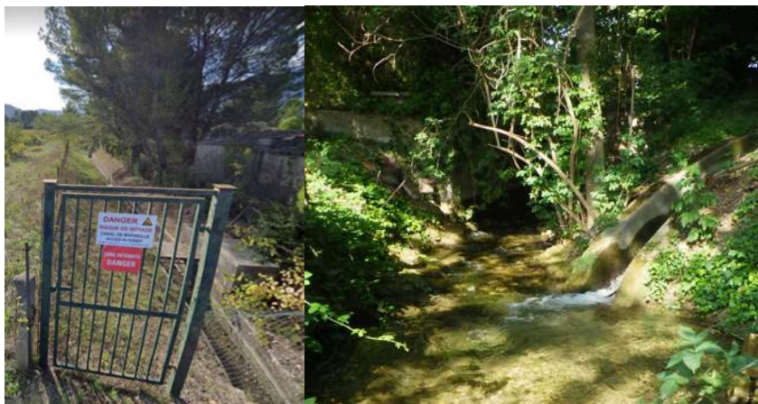
Photos 46 et 47 : Vue du canal de la SEM et de sa restitution au Fauge.
