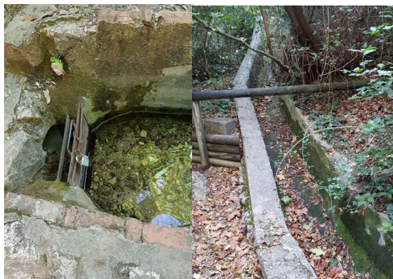
Photos 40 et 41 : Vannette alimentant l'ancien canal d'irrigation des prairies de l'Abbaye.
