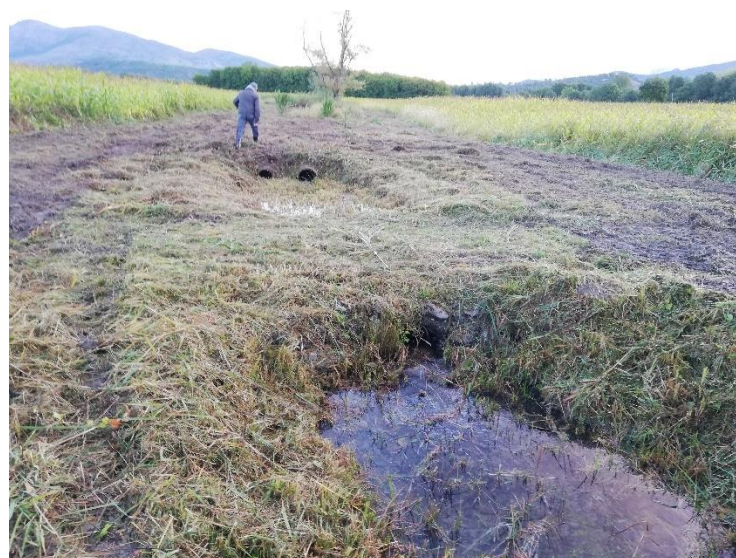
Figure 3 : Retrait et remplacement de l'ouvrage n°3, vu par l'aval.
