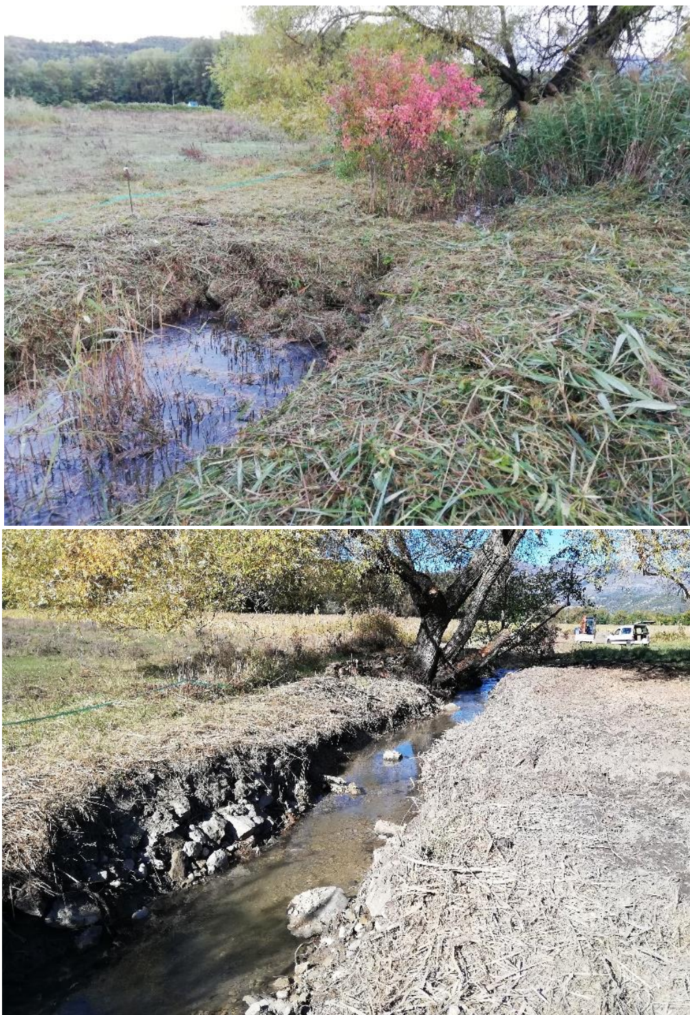
Figure 1 : Avant/après retrait de l'ouvrage n°1, vu par l'aval.
