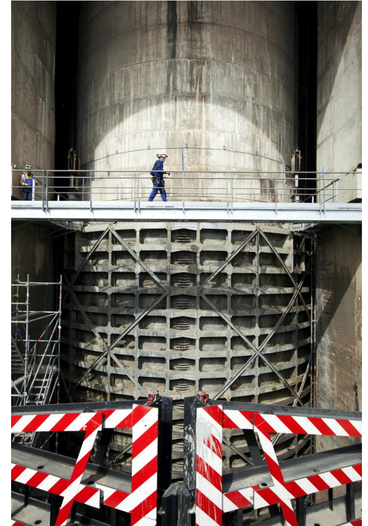
Etat actuel : porte aval vue depuis l'aval
