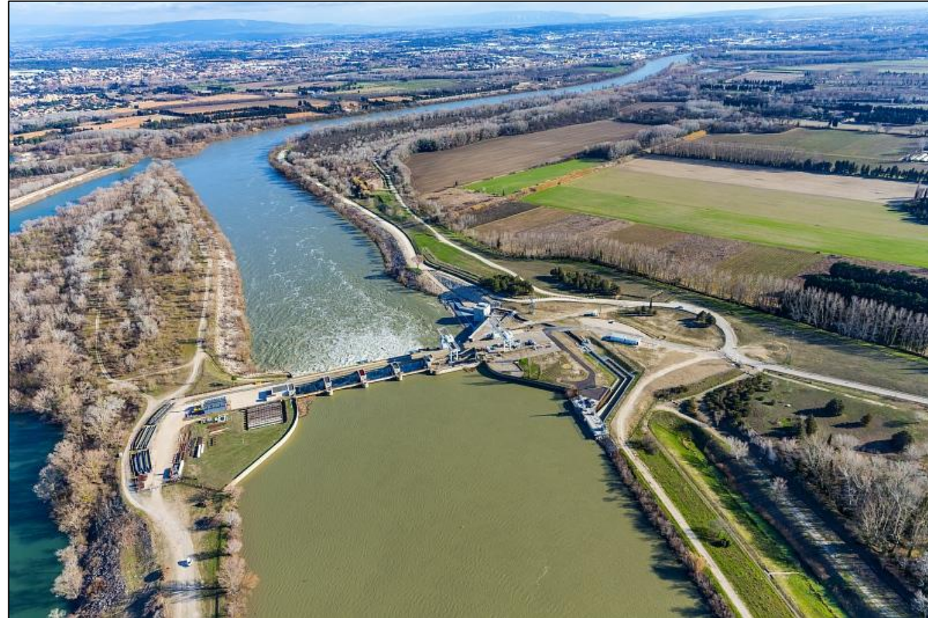
Vue aérienne du barrage de Sauveterre – exemple de configuration en ligne
