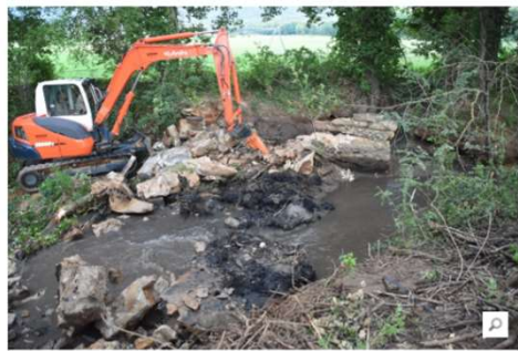
Travaux d'arasement des ouvrages transversaux en cours sur le Malaurie, affluent du Verdon dans le Var
