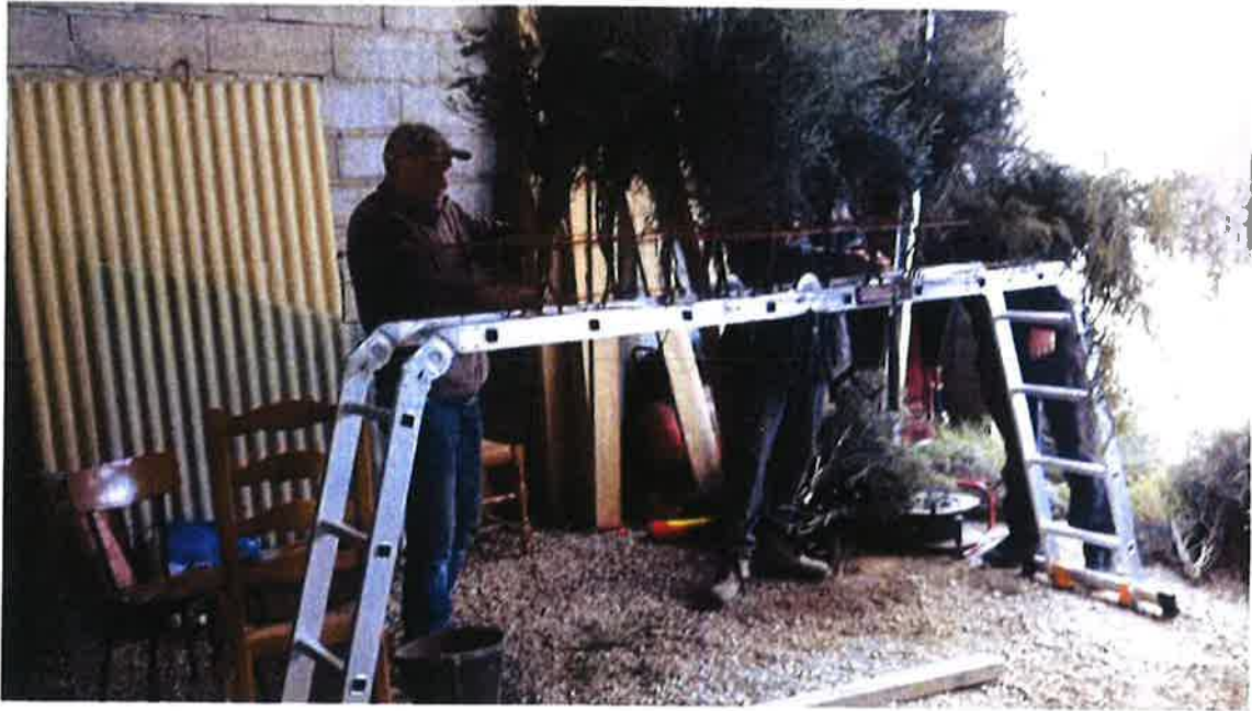
Fixation des brandes de bruyère sur les treillis
