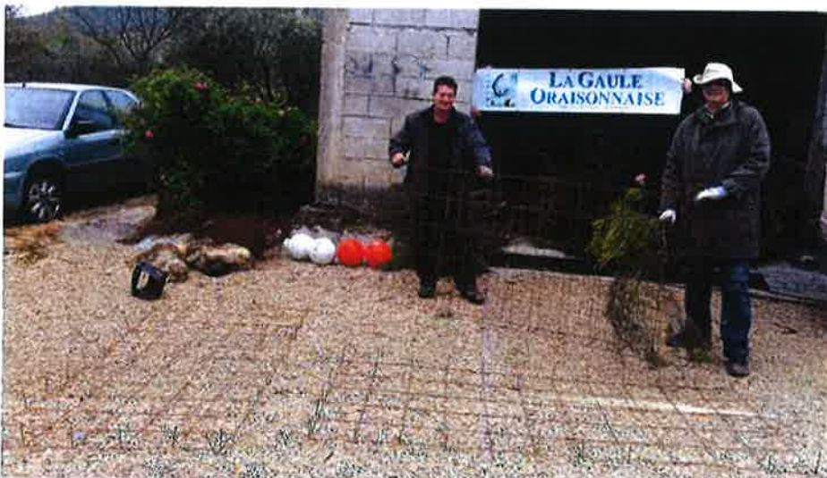
Réalisation des treillis métalliques
