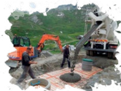
Pose d'une fosse toutes eaux. © PNQR
