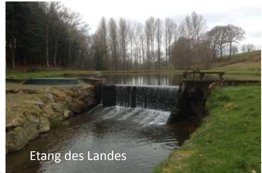
Barrage usine des Fontaines
