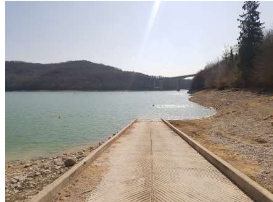
Rampe de mise à l'eau – Retenue de Vouglans
