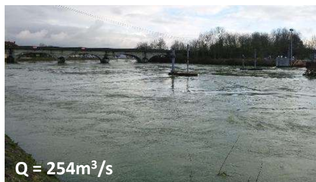
Barrage à aiguilles couché = franchissable
