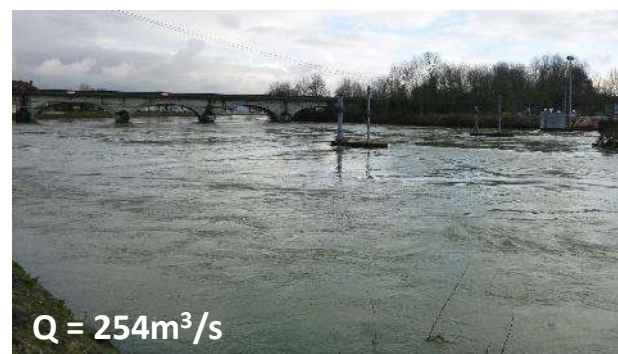
Barrage à aiguilles couché = franchissable
