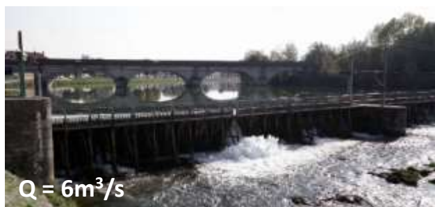
Barrage à aiguilles levé = infranchissable
