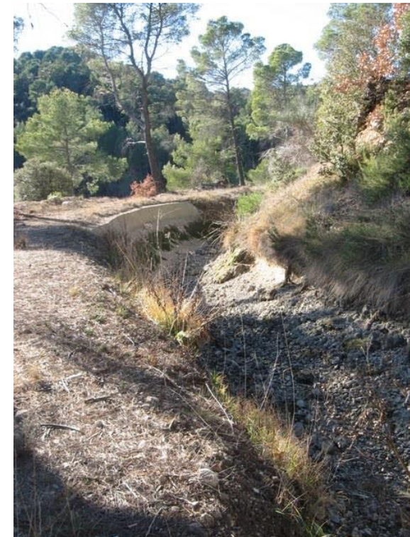
Canal de Manosque avant cuvelage
