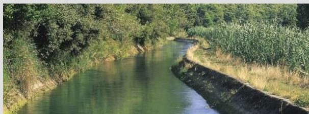
Irrigation canal gravitaire (84) Source : Agence de l'eau RMC
